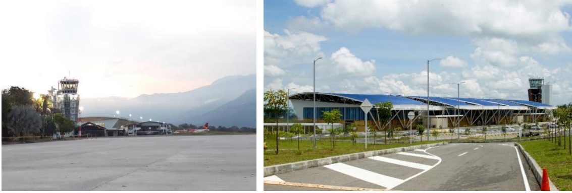
Fuente. Dirección de Infraestructura y Ayudas aeroportuarias. Aerocivil
