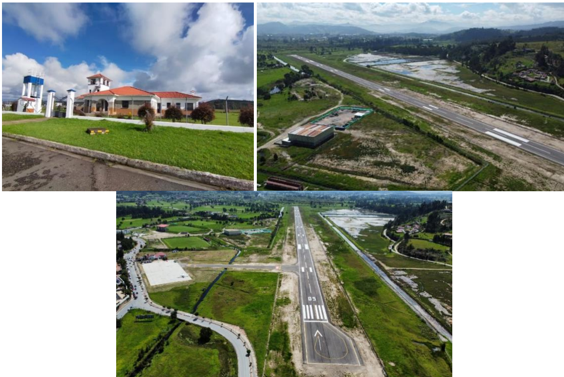
Fuente. Dirección de Infraestructura y Ayudas aeroportuarias. Aerocivil
