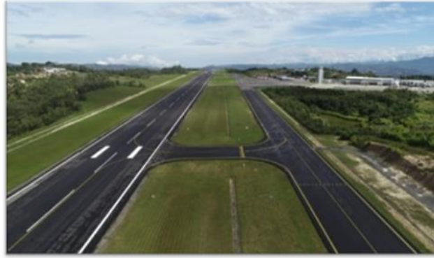
Fuente. Dirección de Infraestructura y Ayudas aeroportuarias. Aerocivil
