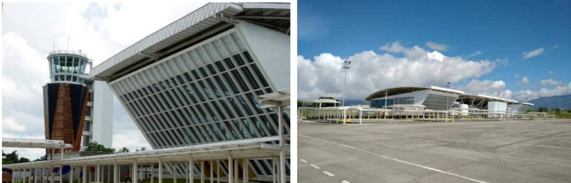
Fuente. Dirección de Infraestructura y Ayudas aeroportuarias. Aerocivil
